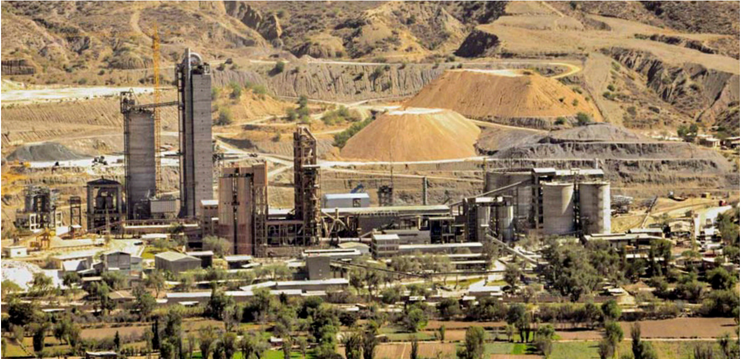
Fábrica de Cemento Coboce
