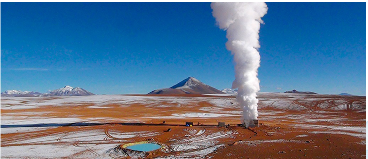
Geotérmica Laguna Colorada
