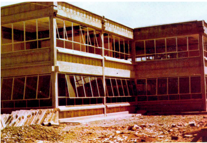
EDIFICIO ENDE EN CONSTRUCCION (COCHABAMBA)
