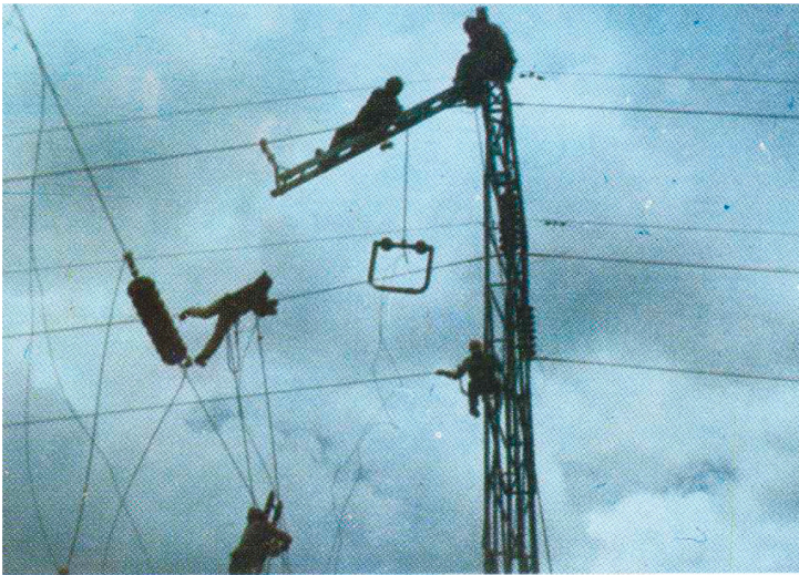
Ajuste de Chicote para Derivación — Sub Estación San Florencio
