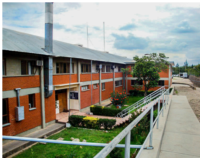
El predio se encuentra ubicado sobre la Avenida Centenario.
